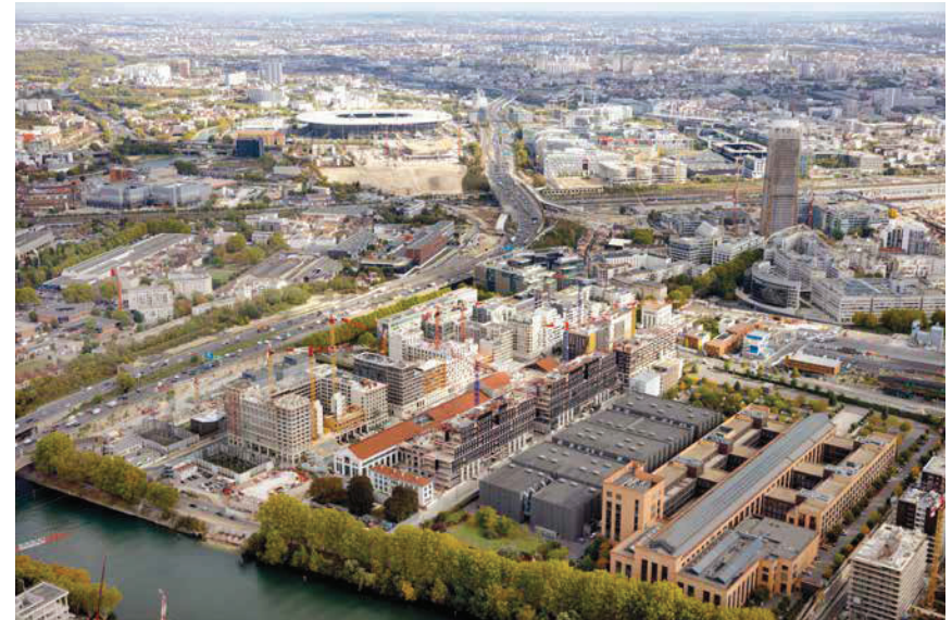
Village des athlètes, prolongement de la ligne 14 du métro vers le nord et terminus Saint-Denis Pleyel, aménagement du système d'échangeurs Pleyel/A86, etc. : VINCI Construction conjugue l'ensemble de ses métiers pour contribuer à accueillir, dans de bonnes conditions, les Jeux Olympiques et Paralympiques de Paris 2024 sur la zone d'Universeine.
