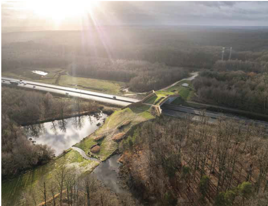
Écopont de Vierzon sur l'A71, pour faciliter les déplacements de la faune et préserver la biodiversité.
