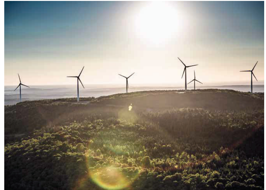
Depuis 2000, les entreprises du réseau Omexom ont installé plus de 10GW d'énergies renouvelables (solaire et éolien).
