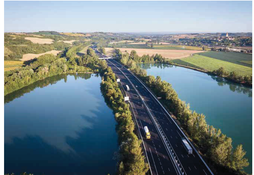
Aménagement à 2x3 voies de l'A61 sur 35 km entre Toulouse et Narbonne. Ici, à proximité des aires de Port-Lauragais.
