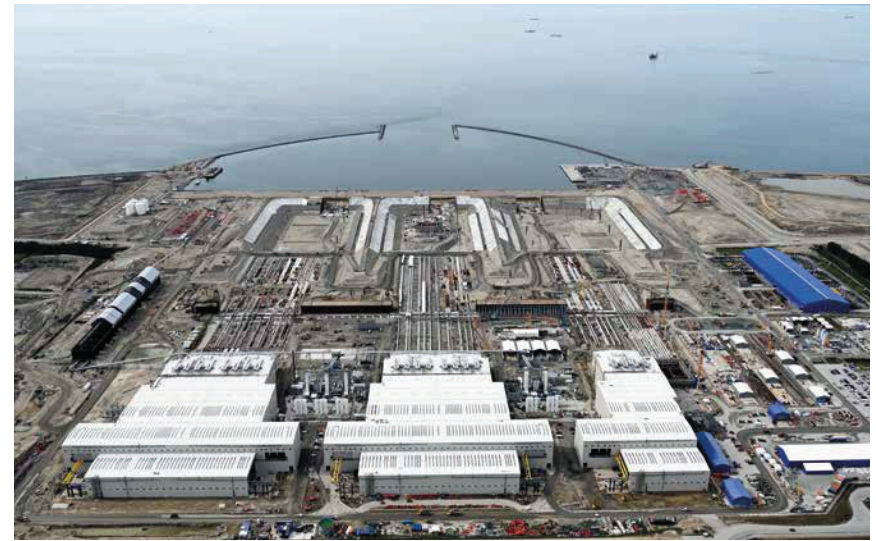
Au Danemark, la construction de l'usine de préfabrication des 89 caissons qui formeront le tunnel du Fehmern, plus long tunnel immergé du monde, s'est achevée en août 2023.
