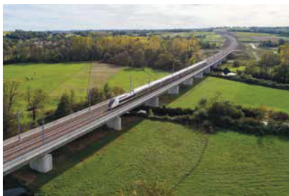
Plus de la moitié des sillons de la LGV SEA restent disponibles dans le cadre de l'ouverture à la concurrence du transport ferroviaire de voyageurs.
